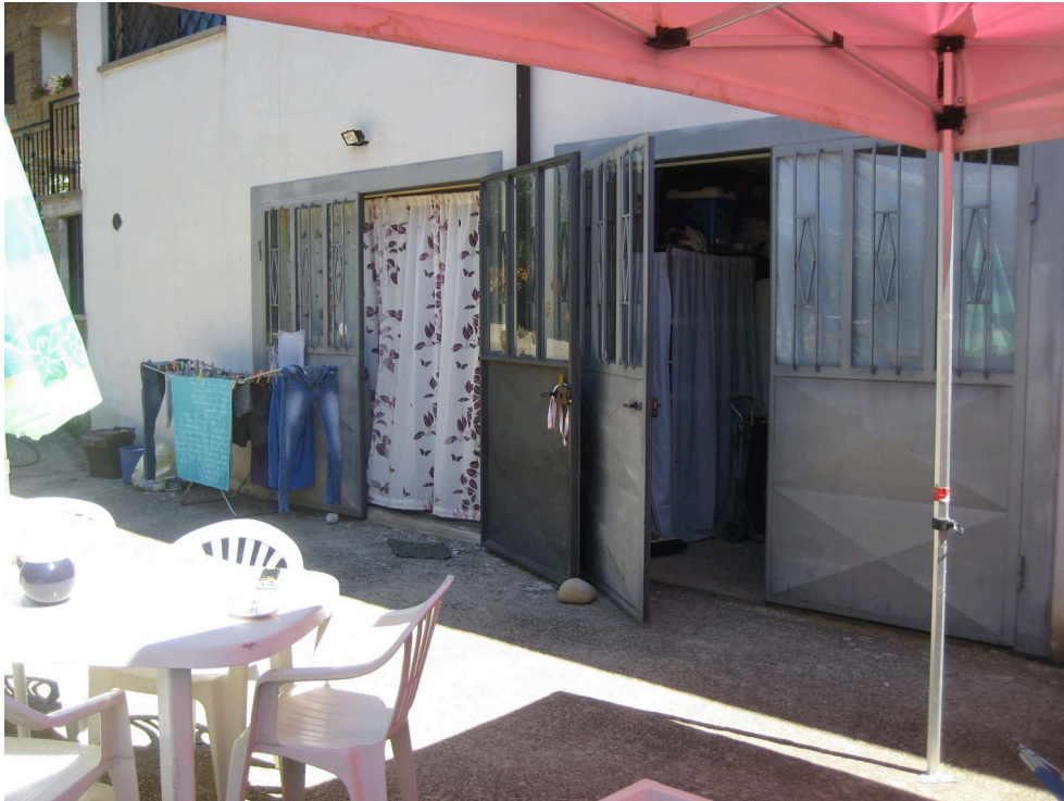
10 – Ingressi ai locali del piano interrato
